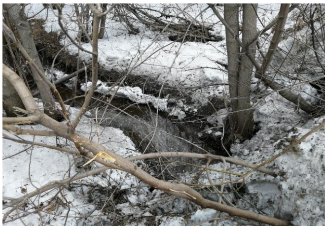
Входное русло водопропускных труб под дорогой на ул. Станционная
