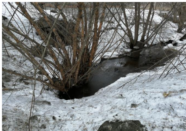
Выходное русло водопропускных труб под дорогой на ул. Станционная
