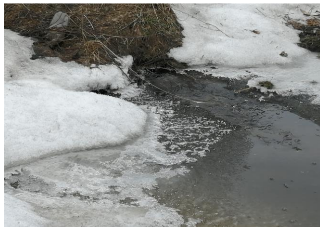
Выходное русло водопропускных труб под дорогой на ул. Речная
