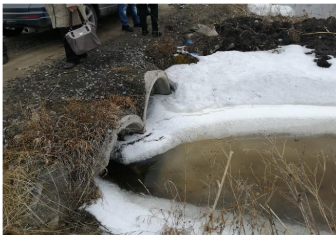
Входное русло водопропускных труб под дорогой на ул. Речная
