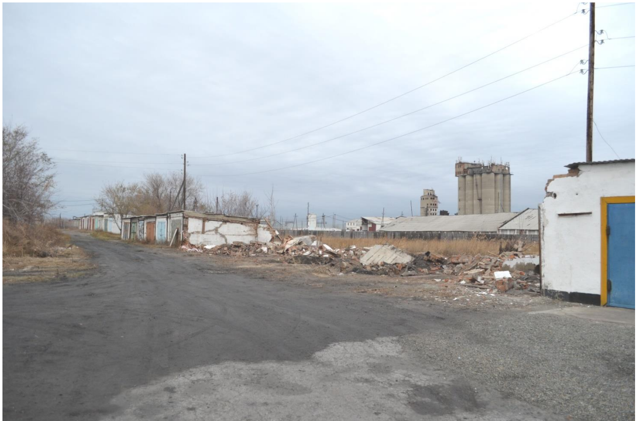
Демонтированные гаражи на земельном участке под строительство автомобильной дороги
