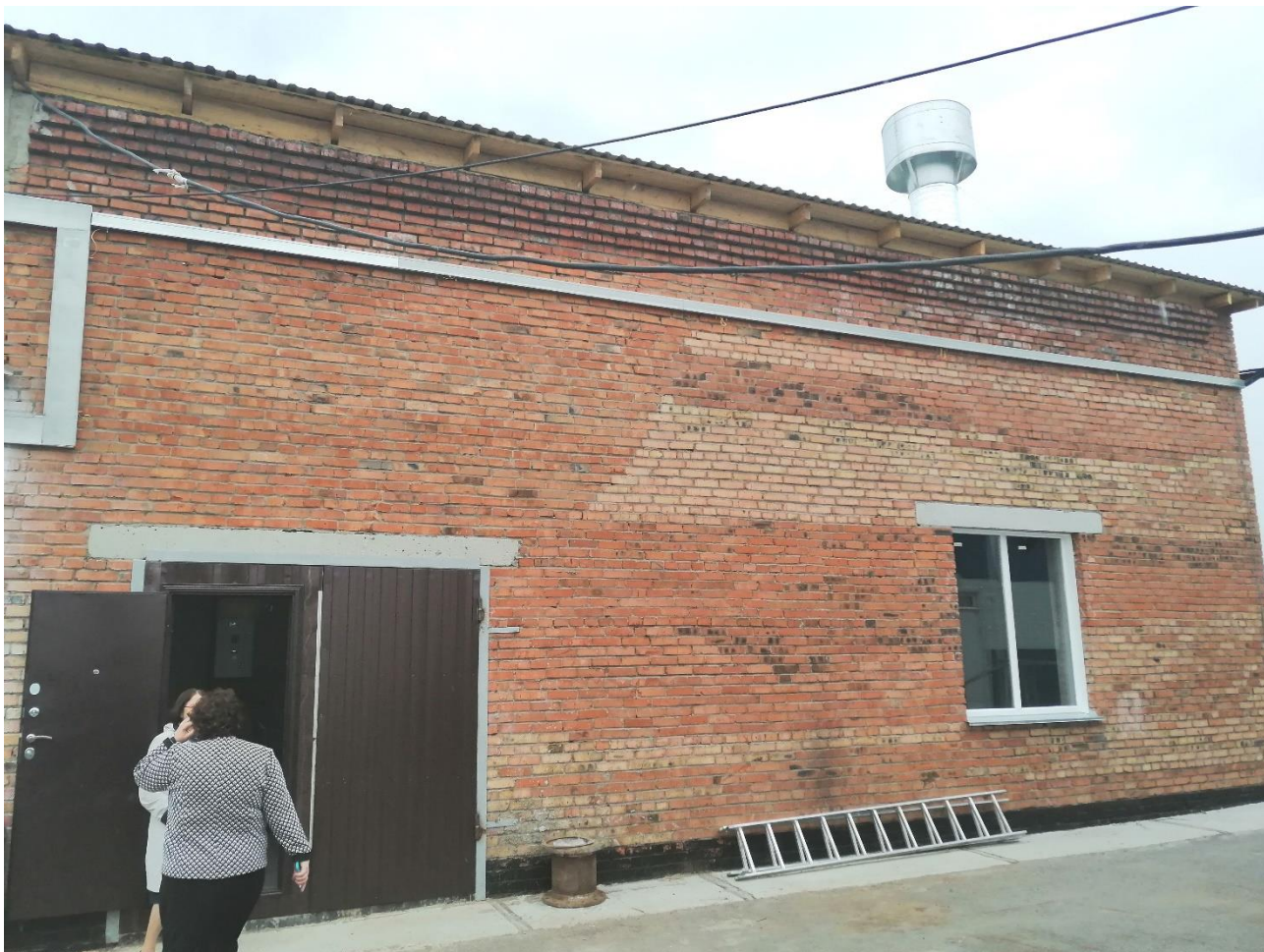
Станция 2-го подъема воды
