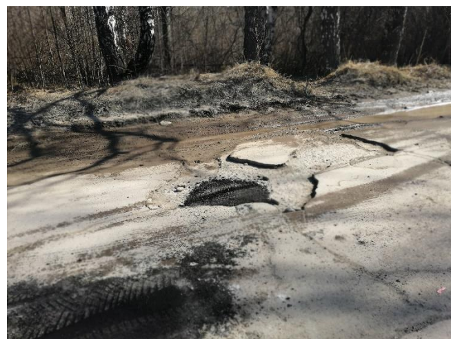
Ямочный ремонт дорожного полотна
