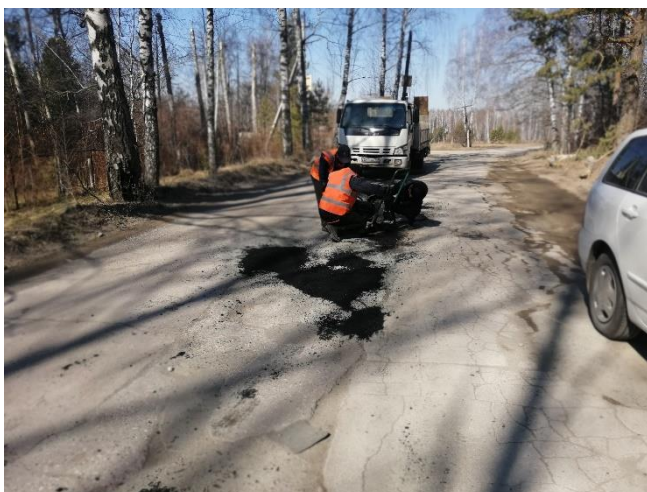
Ямочный ремонт дорожного полотна
