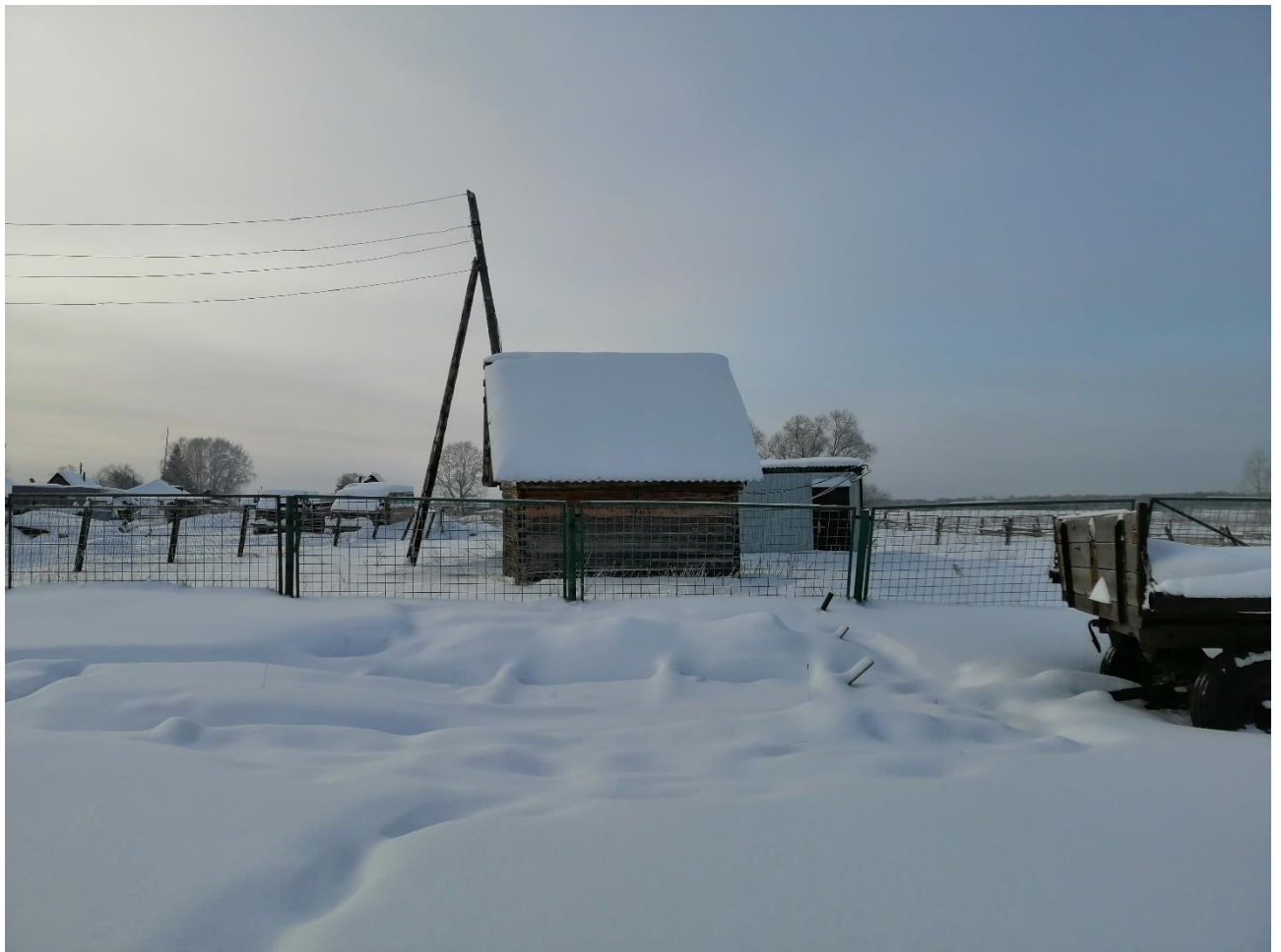
Старая, вышедшая из строя водозаборная скважина, с модулем водоочистки
