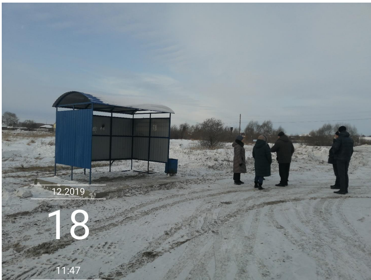
Остановочный павильон с разворотной площадкой на конечной остановке в с. Шилово Новосибирского района
