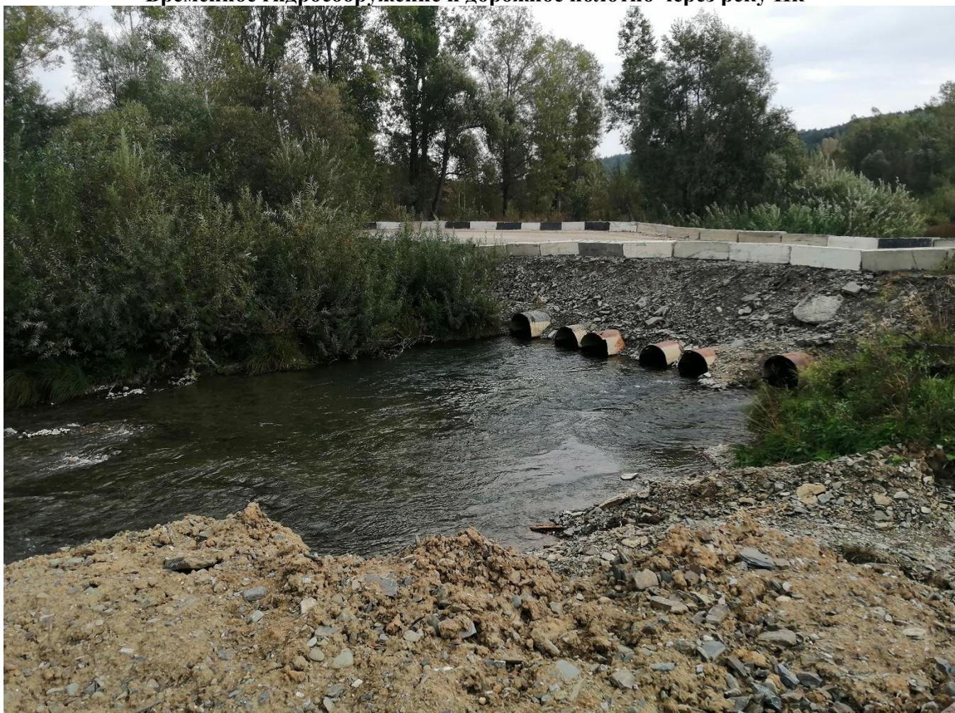
**Отсыпка грунтом подхода мостового перехода на левом берегу реки Ик**
