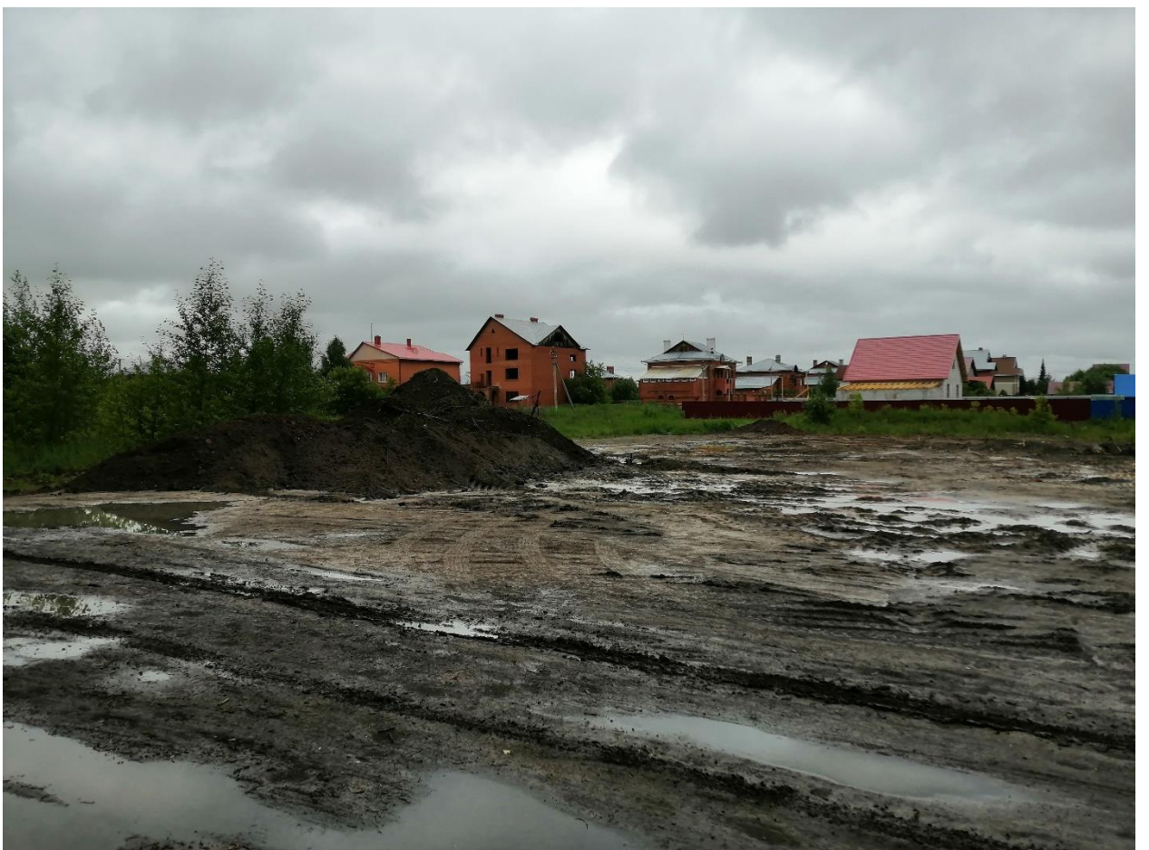
Засыпанный строительный котлован по ул. Геодзическая, 7/1 в г. Оби
