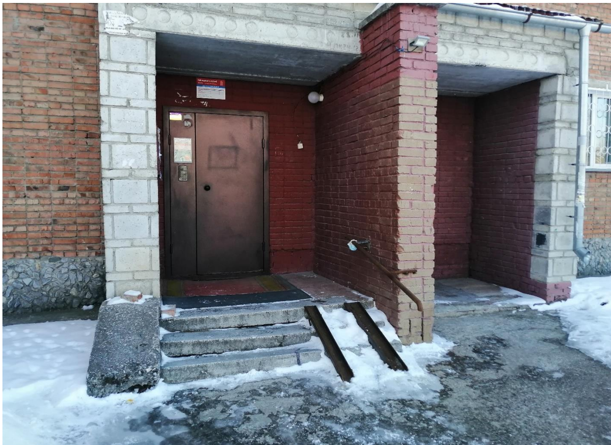
Установка двухсекционного складного пандуса в подьезде
