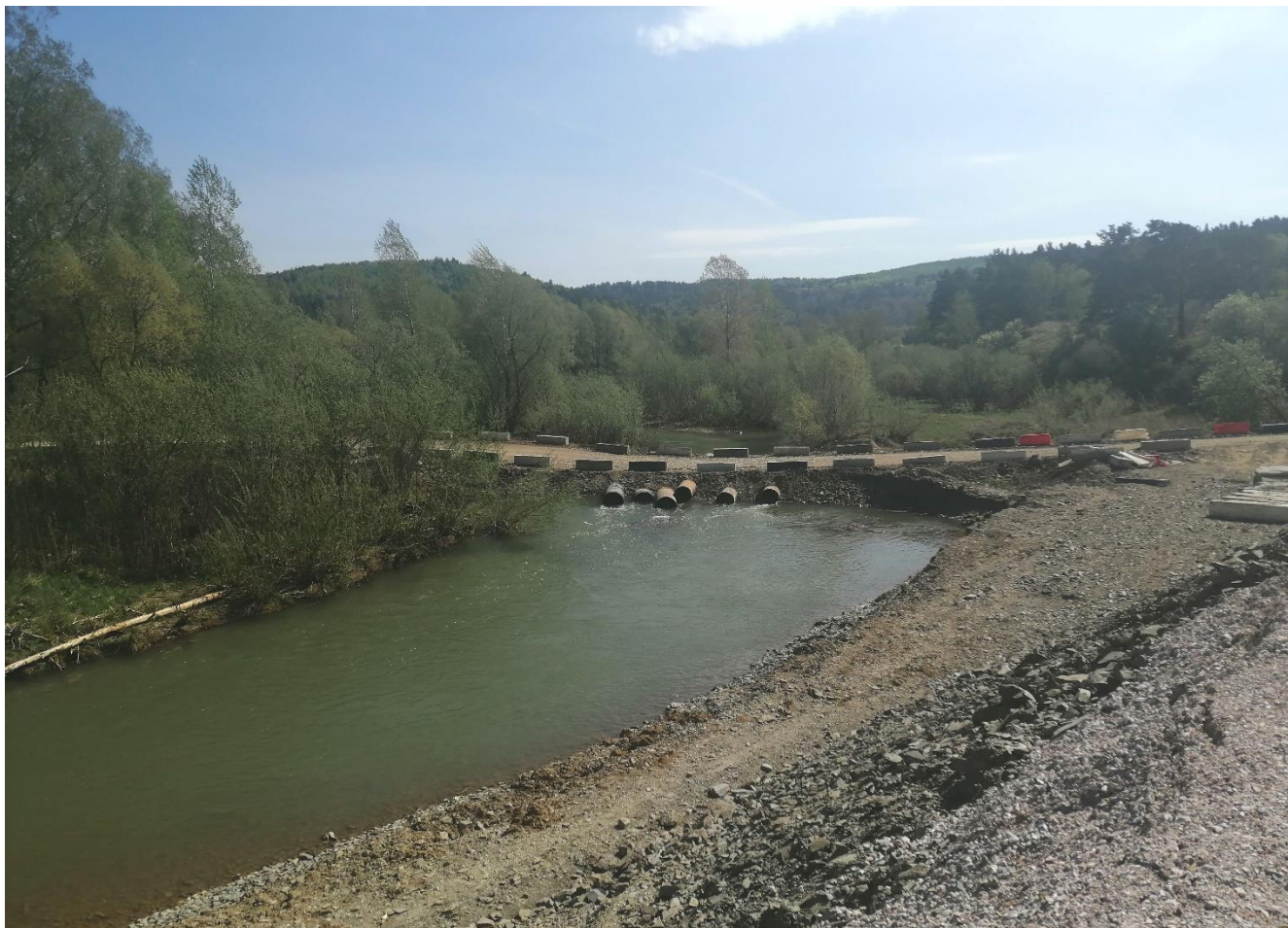
(Объездная дорога с гидропропускным сооружением)
