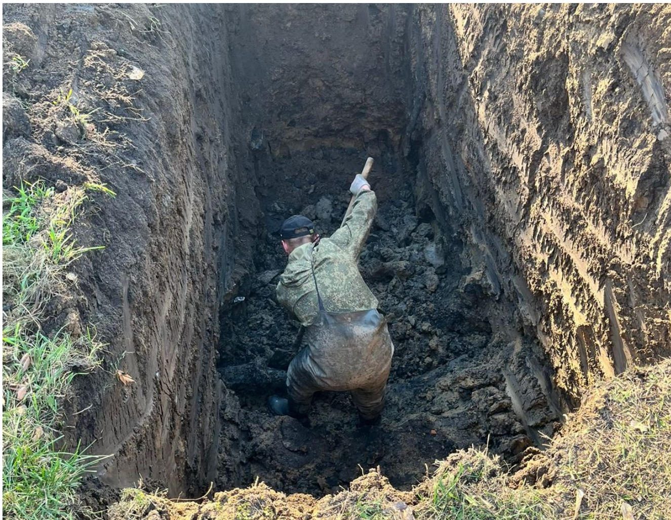
Замена аварийных участков водопроводных сетей на ул. Чкалова в с. Черновка
