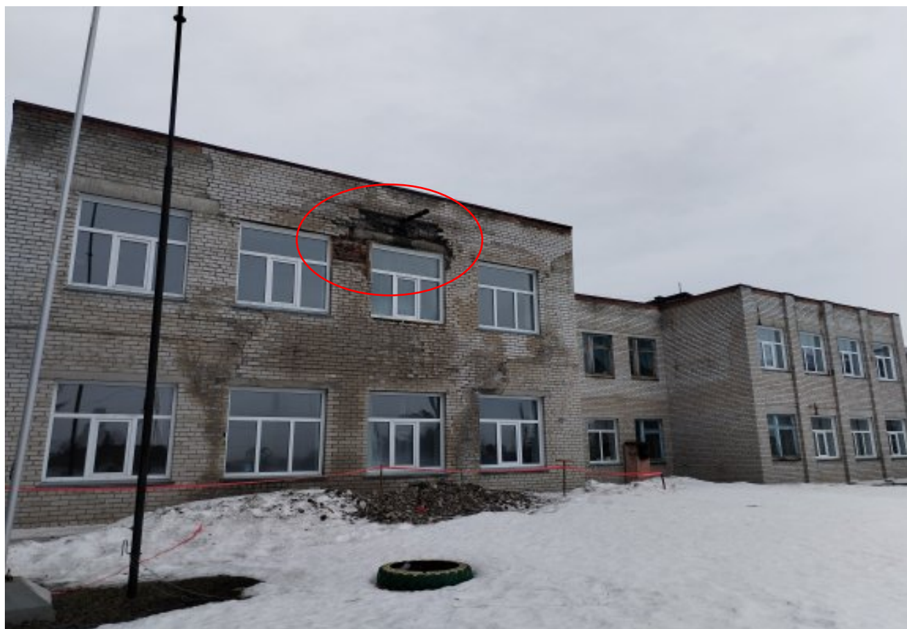
Частичное разрушение кирпичной кладки наружных стен учебного корпуса старших классов
