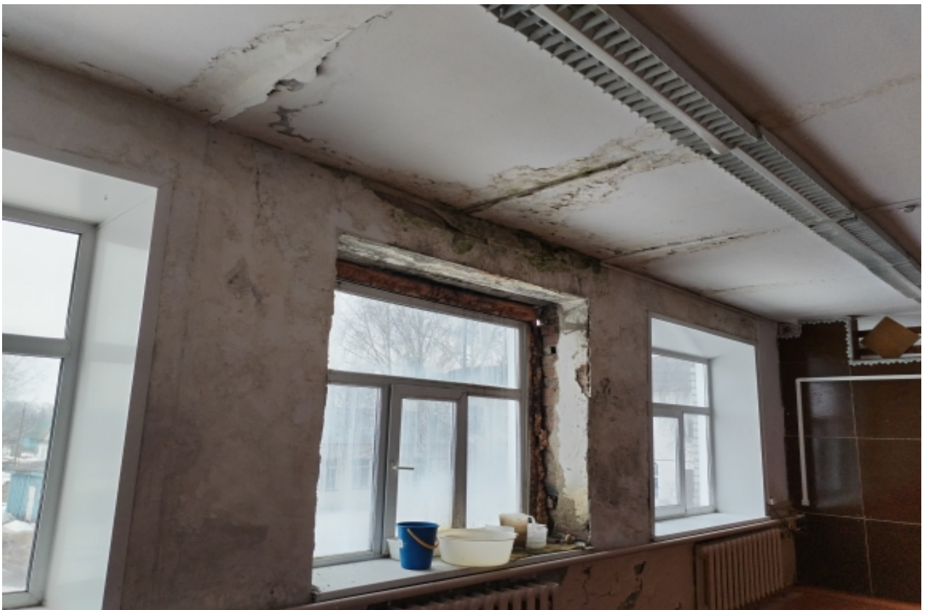
Учебный класс в котором произошло разрушение кирпичной кладки наружной стены
