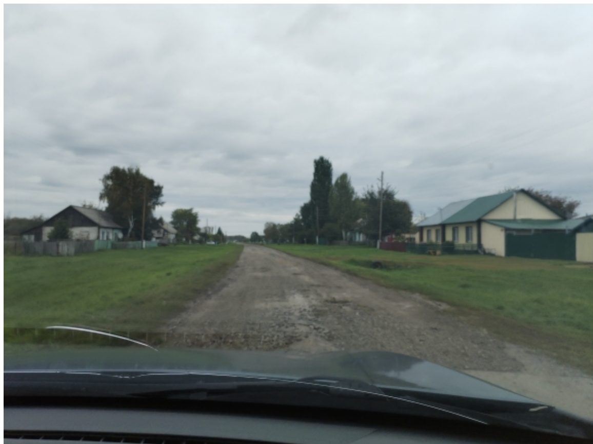
Автомобильная дорога по ул. Школьная в с. Борисоглебка
