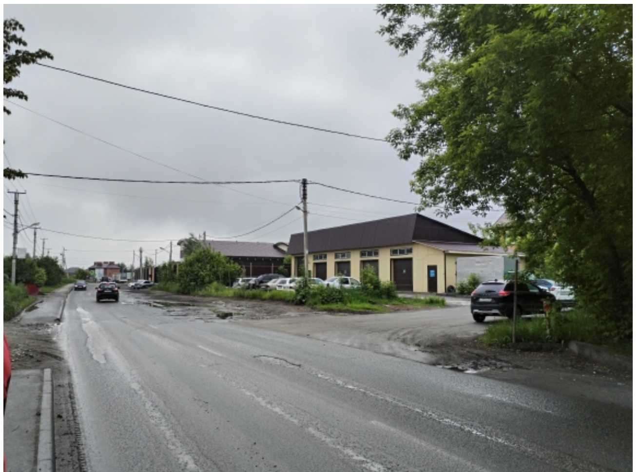
Колейность и выбоины на дорожном покрытии по ул. Прокопьевская
