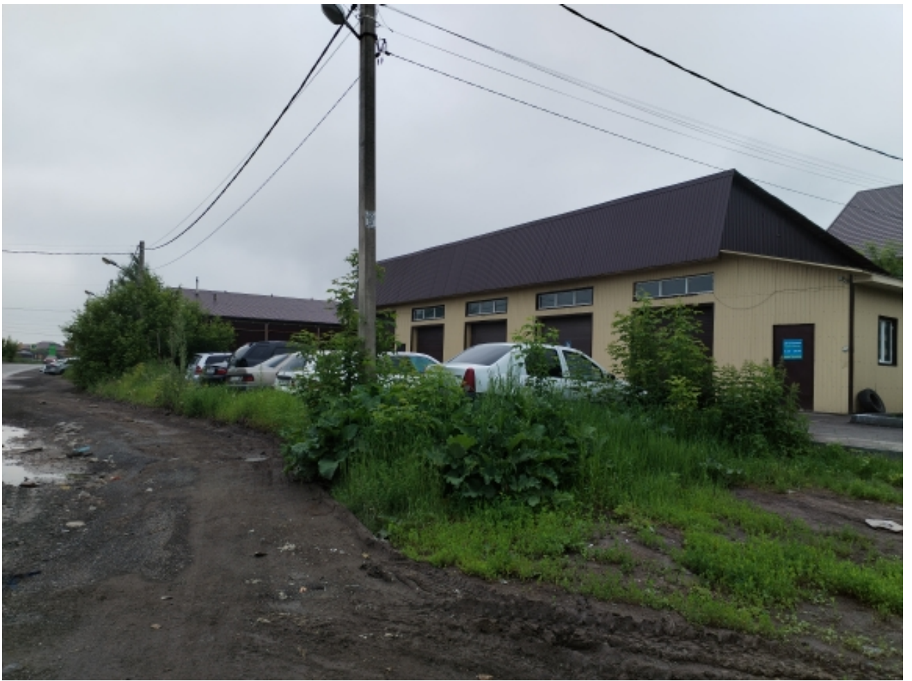
Колейность и выбоины на дорожном покрытии по ул. Прокопьевская
