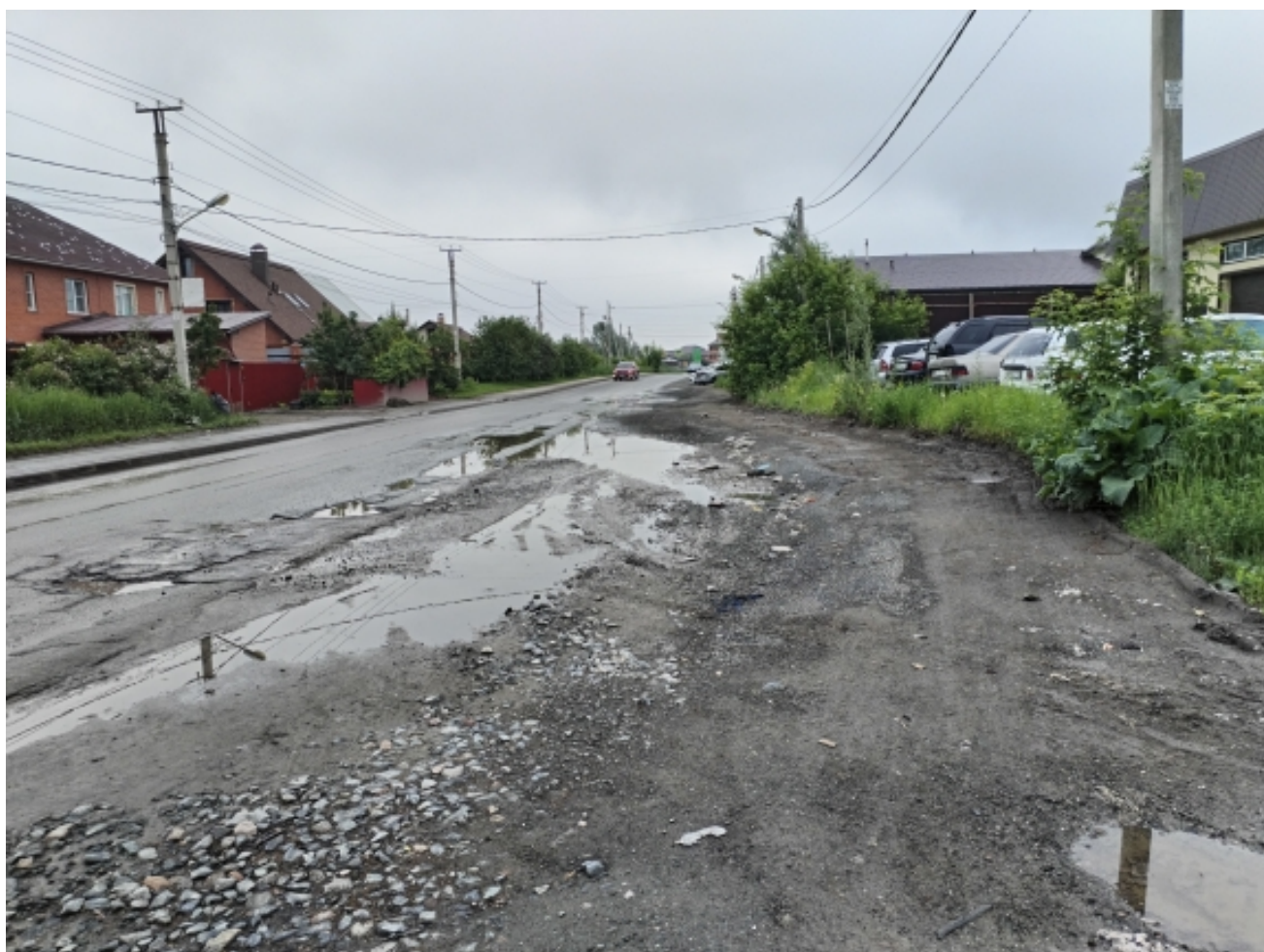
Аварийно - опасный участок дороги (скопление дождевой воды возле СТО по ул. Федора Горячева, 50)
