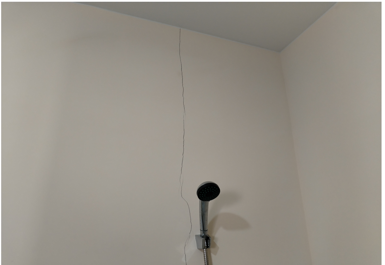
Трещина на смежной стене в санузле соседней квартиры
