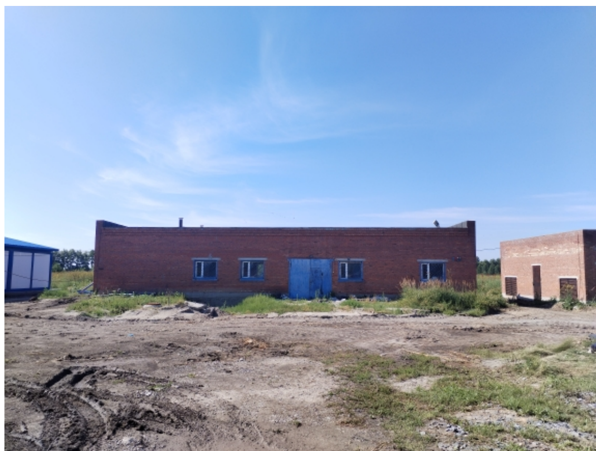
Насосная станция второго подъема
